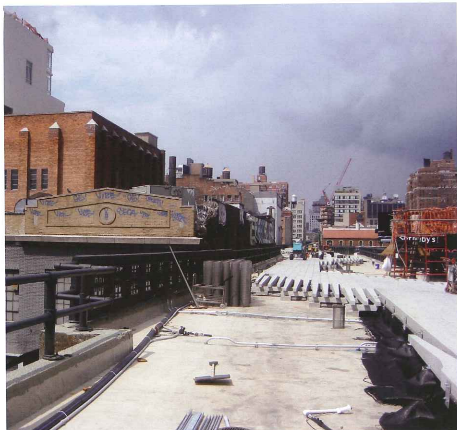
Werkzaamheden High Line, Friends of the High Line
